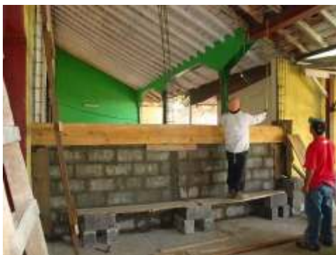
Erneuerung der Wände im Frauenzentrum El Viejo
